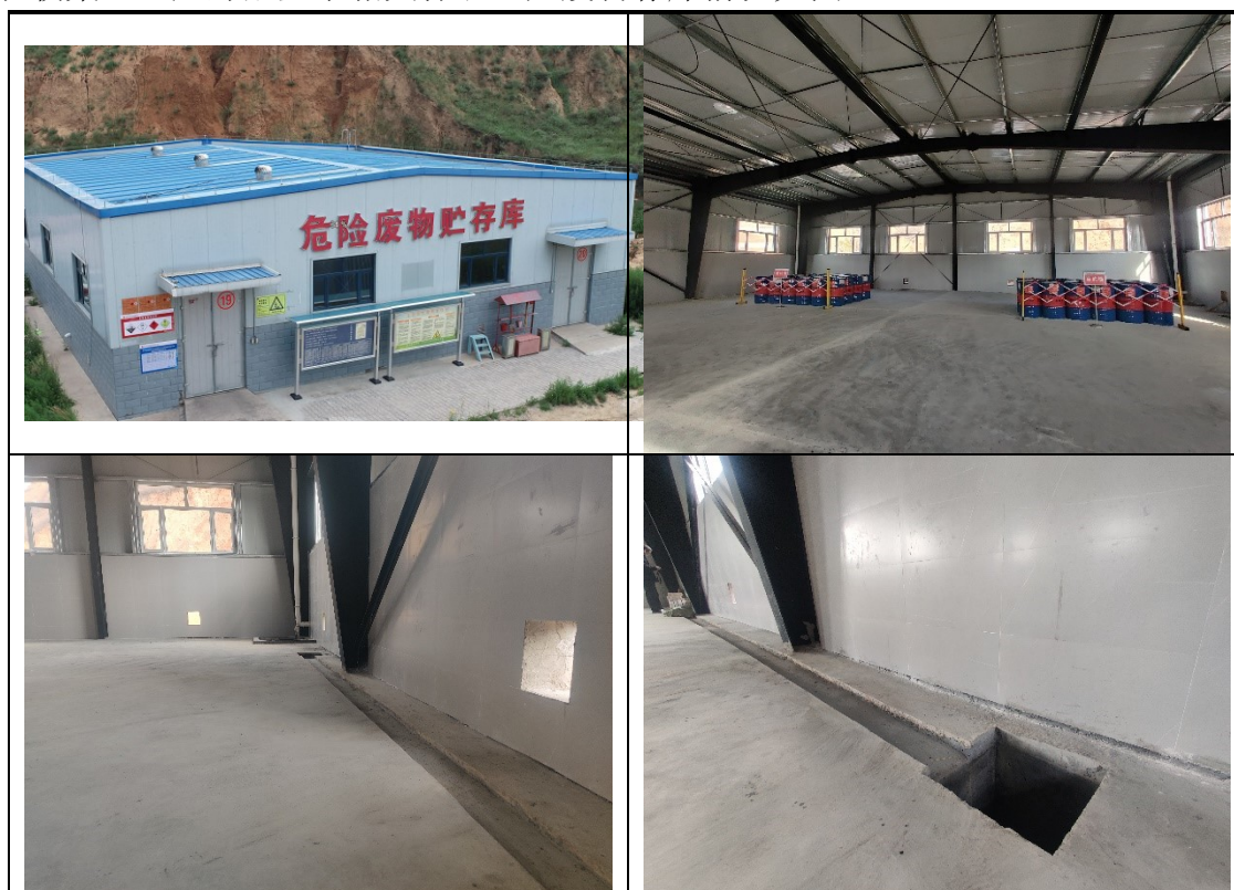
图 9.2-8 危废暂存库现状
