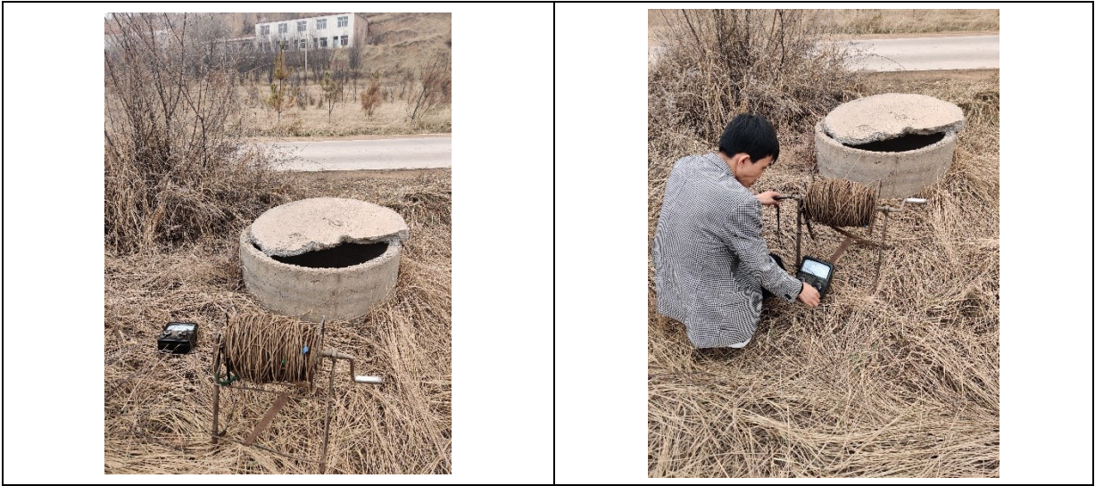
图 5.4-4 现场观测照片
