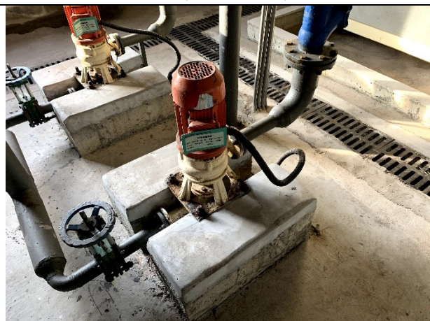
水泵减震基础
