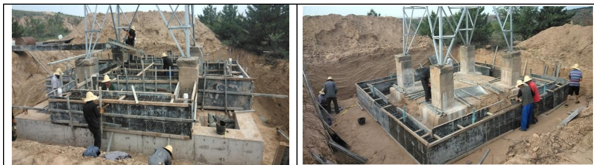
图 4.3-11 塔基现场施工图
