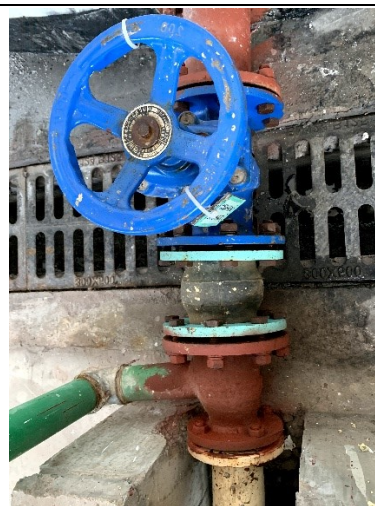
水泵橡胶连接
