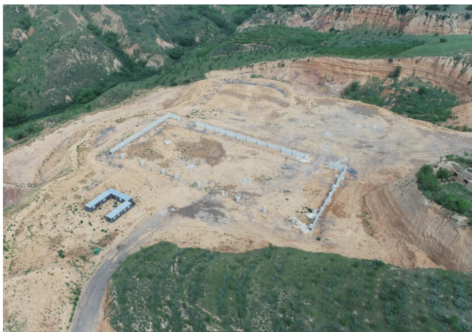
图 9.2-6 固废综合再利用项目建设现状
