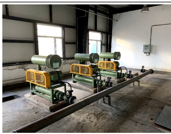
鼓风机减震基础
