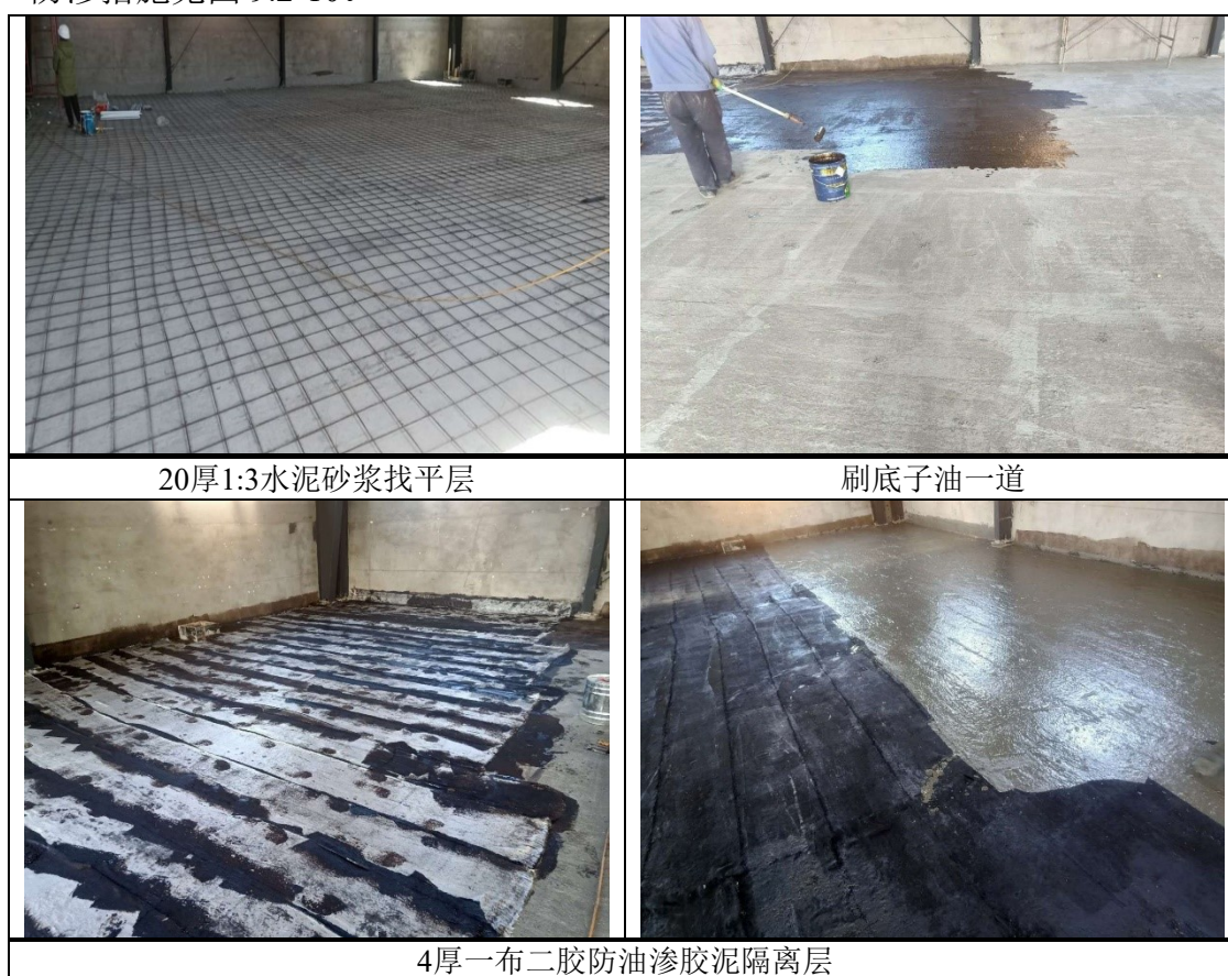
图 9.2-10 危废暂存库防渗措施现状
