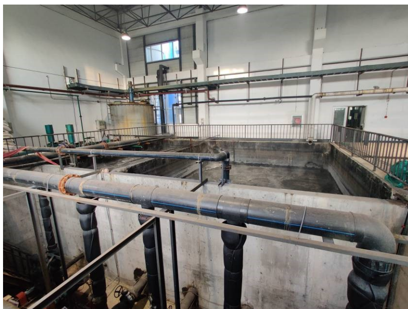
图 7.2-6 脱硫废水处理系统
