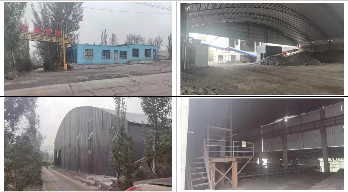
图 9.2-3 内蒙古衡新资源综合利用有限公司现场照片
