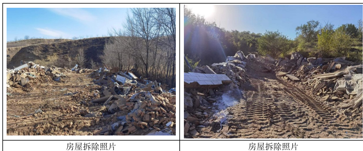
图 4.3-8 搬迁房屋迹地情况
